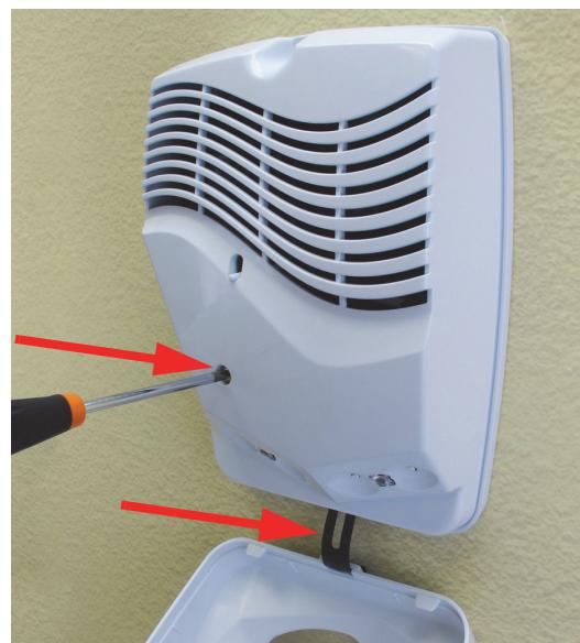
Aprire il coperchio interno rimuovendo la vite posta sopra la barra dei led. Sfilare il coperchio interno, spostandolo leggermente verso destra e posizionarlo sul coperchio esterno che, con la sua conformazione, lo potrà sorreggere durante le fasi di installazione.
